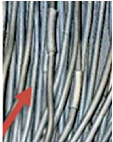
An den Verdickungen in diesem Röhrenge-wirr kann man frühere Reparaturstellen erkennen.
